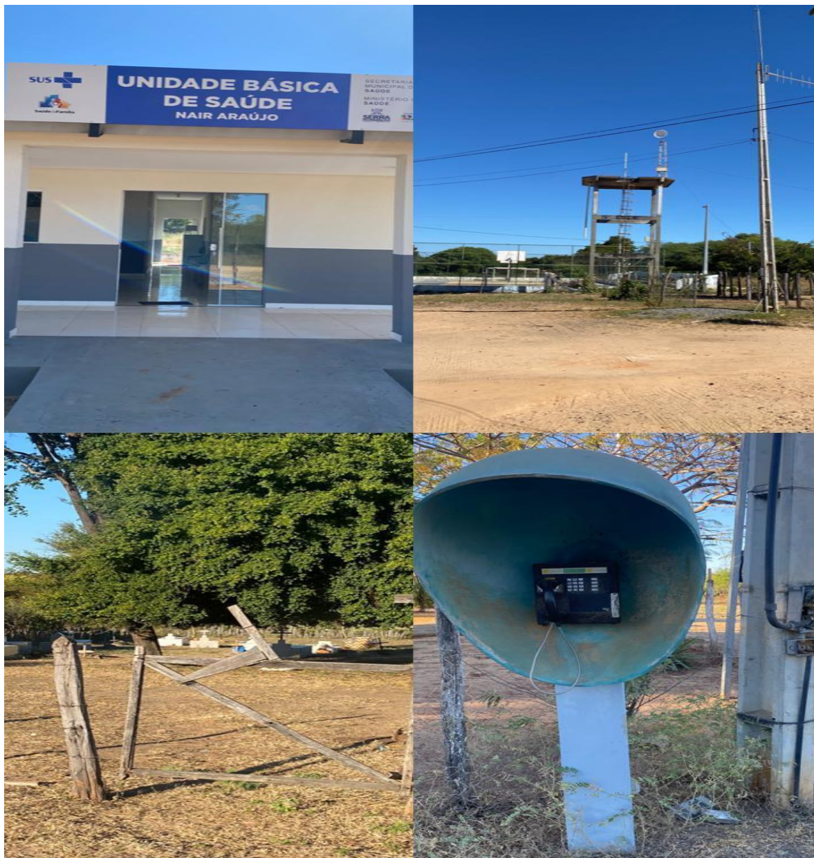
FIGURA 2: PRÉDIOS PÚBLICOS E COMUNITÁRIOS DA COMUNIDADE QUILOMBOLA-RIBEIRINHA DE PAMBU/ARAÇÁ
