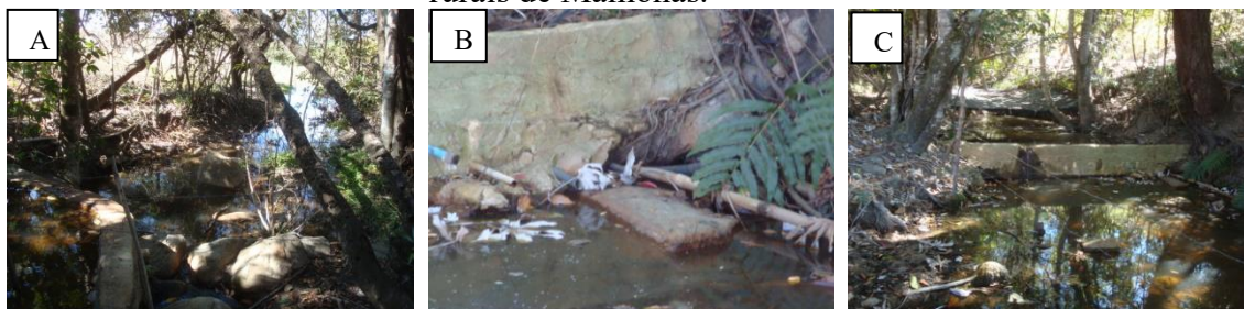
Figura 38 – Trechos característicos do sistema de pena d'água utilizado pelas comunidades rurais de Mamonas.
