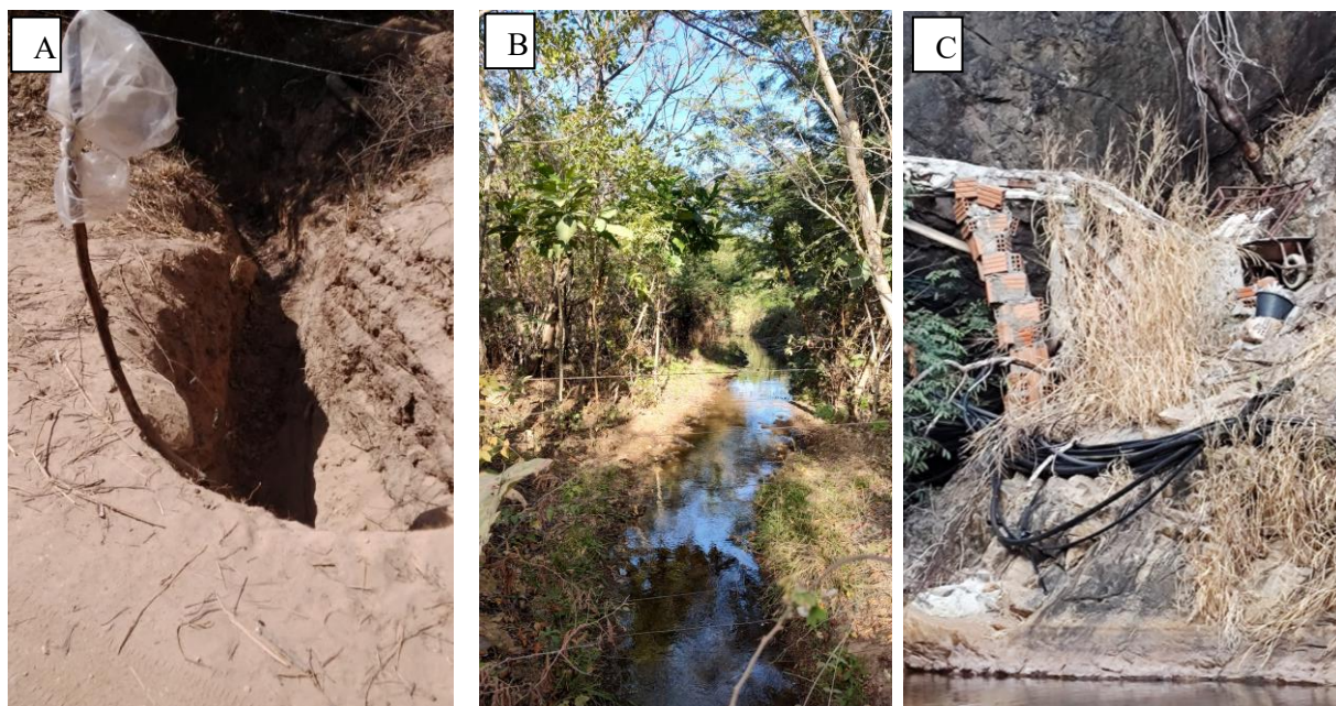
Figura 31 – Formas atuais de captação e condução da água associadas ao sistema tradicional de “pena d’água” no entorno do PEGC.
