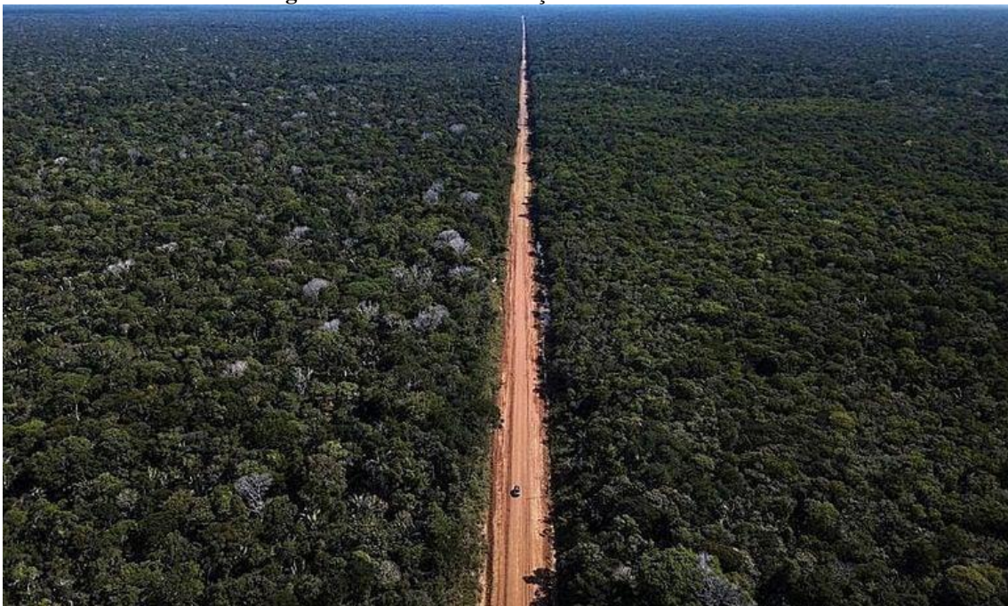
Figura 3 – Obra de reconstrução da rodovia BR-319
