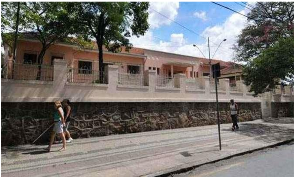
Figura 8 – Instituto São Rafael – Escola para cegos - Antigo prédio do Abrigo Affonso de Moraes.
