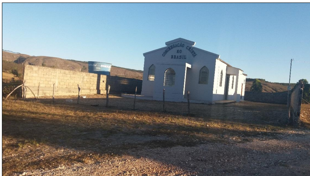
Foto 36: Arquitetura da Igreja da Comunidade.
