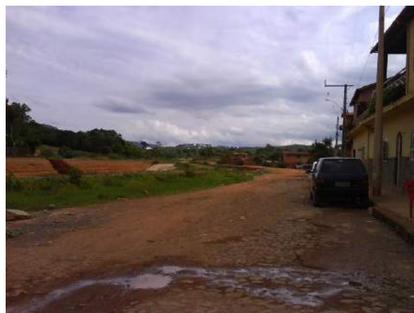
FIGURA 17 - Avenida 'B', situada à margem do Córrego dos Mangues AUTORA: CASTRO, G. F.; 19/01/2009
