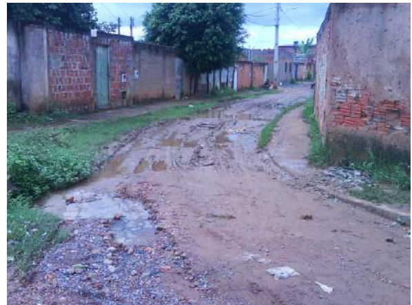
FIGURA 15 - Beco 'E', sem pavimentação. AUTORA: CASTRO, G. F.; 20/01/2009
