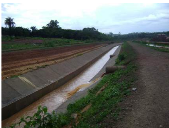
FIGURA 27 - Córrego dos Mangues canalizado AUTORA: CASTRO, G. F.; 19/01/2009
