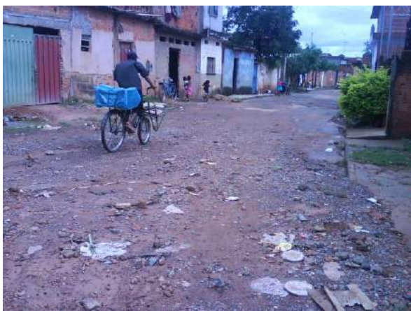
FIGURA 18 - Rua 08, a pavimentação necessita de restauração
