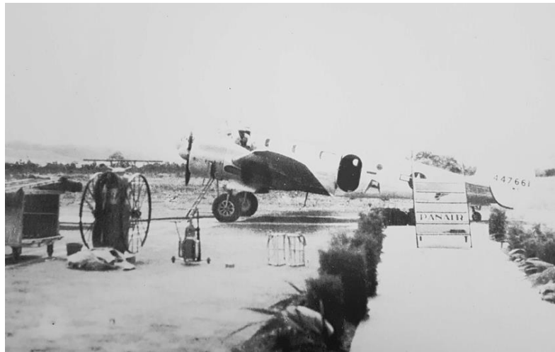
FOTOGRAFIA 7 - Aeroporto de Montes Claros em 1947 38 Fonte: MARQUES; MARQUES, 1989.
