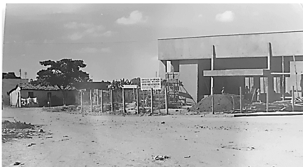
FOTOGRAFIA 15 - Obras da construção do auditório da FEMC Fonte: Acervo FEMC 143 .
